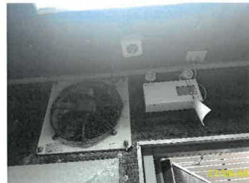
พัดลมระบายอากาศ และไฟส่องสว่างฉุกเฉิน
