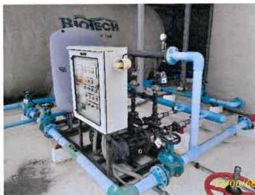
ปั๊ม และถังสำรองเพื่อการอุปโภค-บริโภค ชั้นดาดฟ้า
